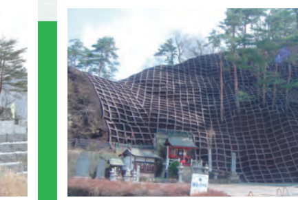
■ 河口湖小曲リトンネル法面工事
