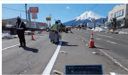
▲国道139号区画線施工
