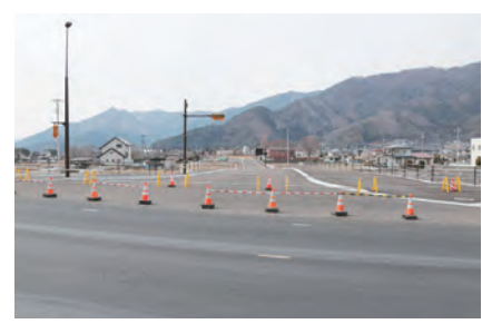
■ 新倉バイパス工事
