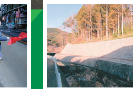
■ 富士河口湖町河口、寺川法面崩落対策工事
