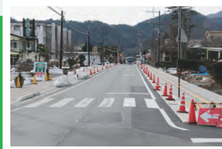
■ 富士河口湖町大石地区電線地中化工事
