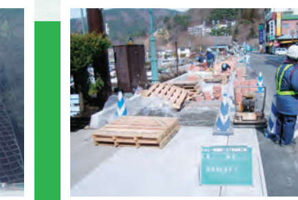
■ 河口湖町船津浜排水工事
