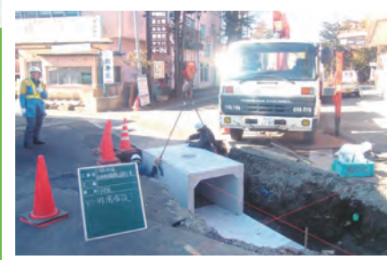
■ 国道413号交差点冠水対策工事
