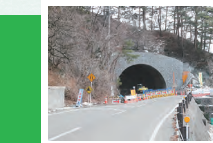
■ 富士河口湖町 扇崎トンネル改修工事
