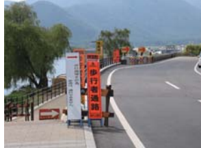
長崎～河口小拡幅工事
