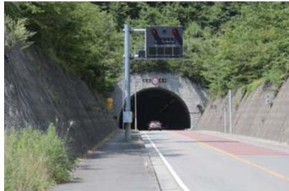
鳥居地トンネル
