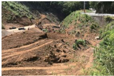
道志トンネル残土処理場工事
