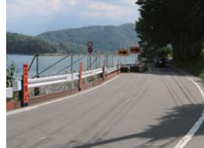
扇崎拡幅工事
