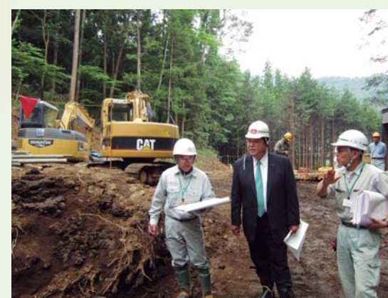
■田屋沢治山工事（都留市鹿留地内）
