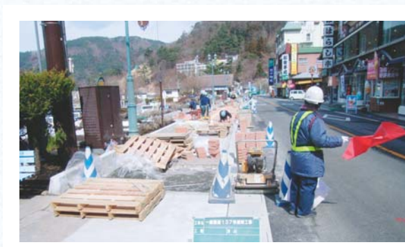
■ 河口湖船津浜みはらし亭前排水工事 これで冠水時に店の中に雨水が入ることが防げます
