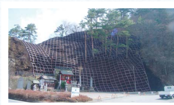
■ 河口湖小曲りトンネル法面工事 長い間放置されていた崩落箇所を改修しました
