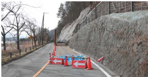
■ 西湖クワルビ…地域要望を受けての西湖クワルビ地区法面改修工事。この区間は落石や降雨時の流れ出しなどが頻繁にあり極めて危険な区間ではありましたが、どういつ訳か大急処置で十数年放置されているというお粗末さでした。ここでようやく私の申し入れによって法面工事を開始しました
