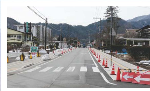
■ 富士河口湖町大石地区の懸案であった若彦交差点からサニードまでの区間歩道新設及び電線地中化工事
