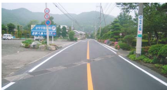
■ 忍野村舗装工事…地域の皆様から自動車通行時の横断溝からの音や、舗装が劣化しているクレームが寄せられ、村道移管前に県で舗装の打ちかえを行いました
