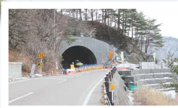
■ 富士河口湖町長浜地区の扇崎トンネル改修工事 もう少しですれ違いができる周遊道路となります
