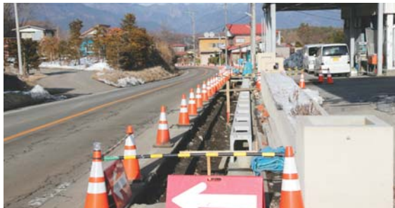
■ 足和田大嵐地区から鳴沢村大和田までの歩道改修工事 古い歩道を改修してのバリアフリー化
