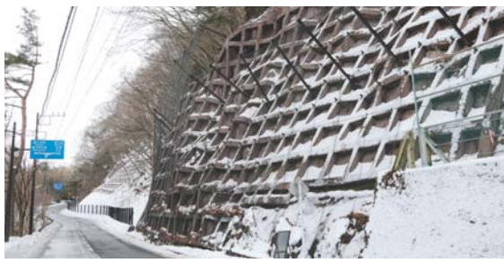
■ 精進湖活性化センター付近法面工事 用地交渉では地域の方々に大変お世話になりました
